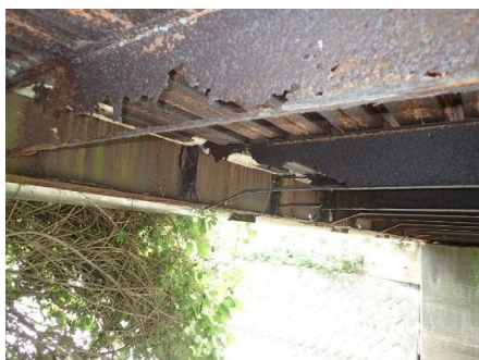
鋼桁の腐食・破断
