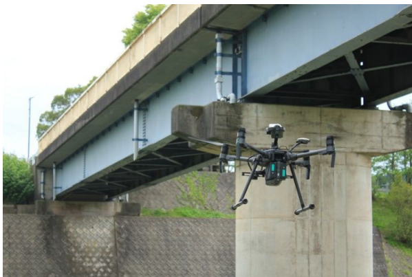
ドローンによる点検状況
