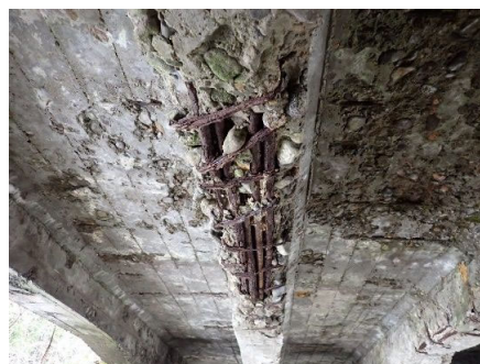
主桁の剥離・鉄筋露出
