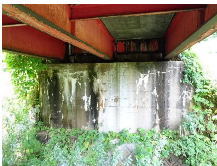
橋台の遊離石灰を伴うひびわれ
