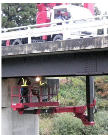
写真3.3 点検車による点検
