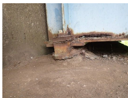
鋼製支承の沓座モルタル欠損、傾斜
