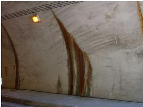
側壁 開口した変状ひびわれ
