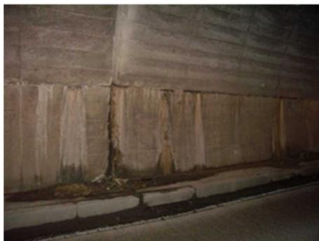
漏水と遊離石灰 目地から土砂流出
