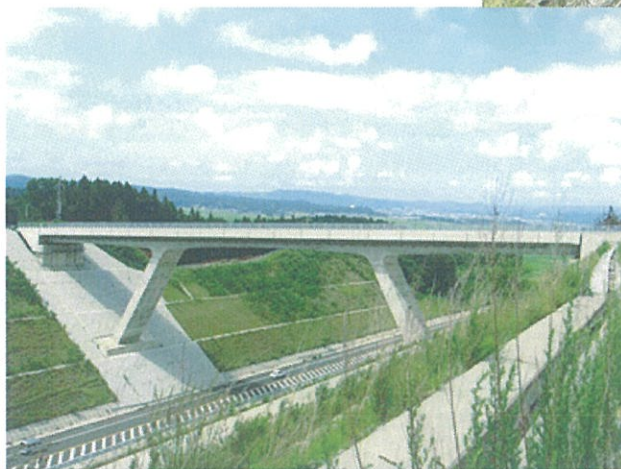
PC ラーメン橋 (湯水沢こ道橋)
