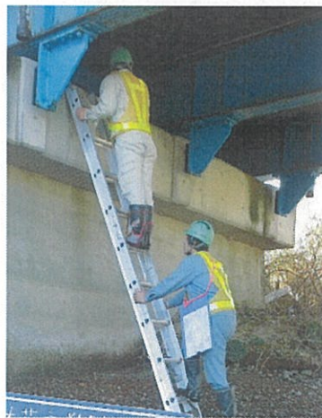
写真3.2 梯子による点検
