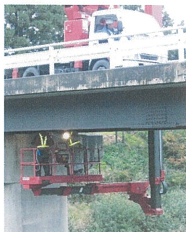
写真3.3 点検車による点検
