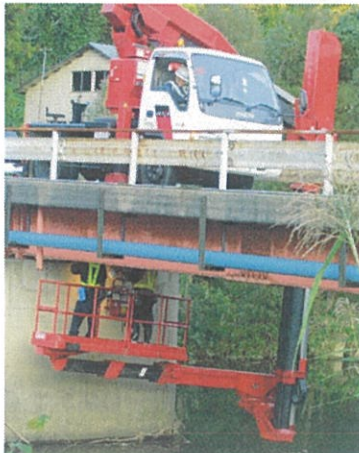
写真3.3 点検車による点検
