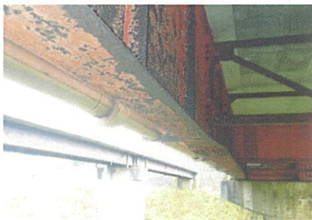
鋼桁の腐食
