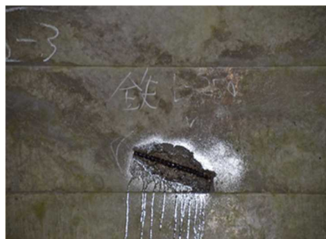
アーチ部の鉄筋露出「Ⅱa」
