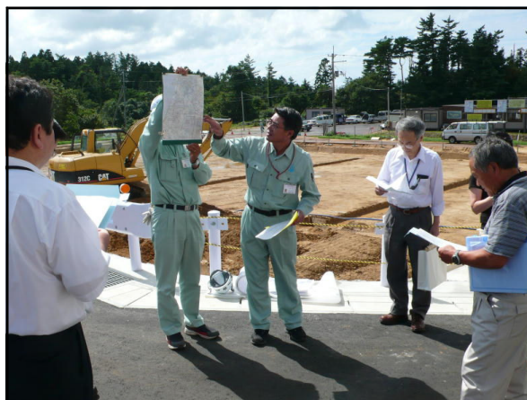
【由利原浄水場の現地調査の様子】
