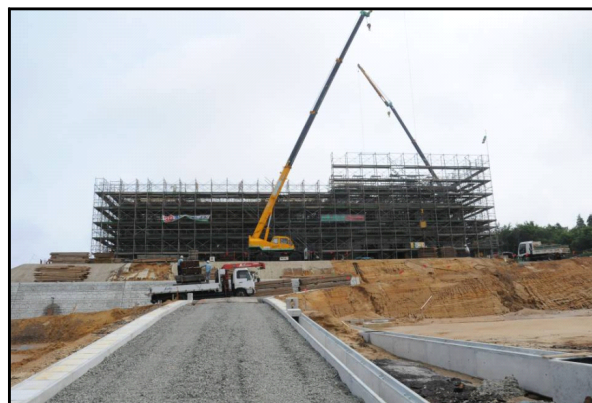
【由利原浄水場浄水棟建設工事の様子】
