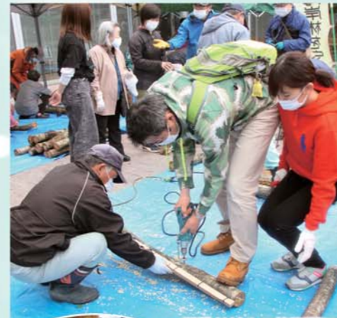
電動ドリルで等間隔に穴を開ける
