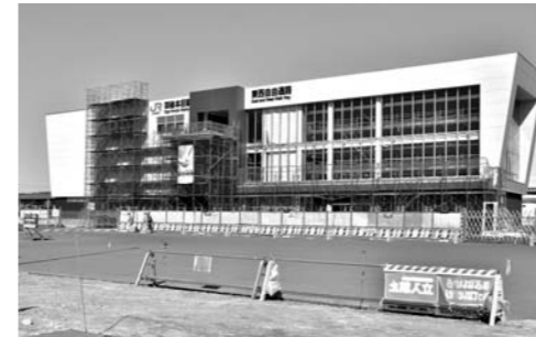
今年8月に開通・完成予定の東西自由通路と新羽後本駅
