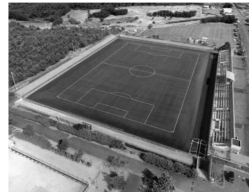
大規模改修を行った西目サッカー場
