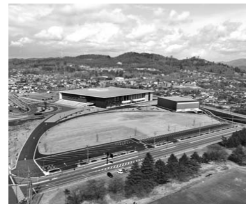
多目的広場などの外構工事が完了した 総合防災公園ナイスアリーナ
