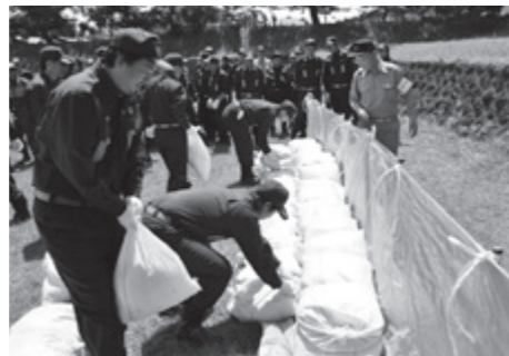
改良積み土のう工
