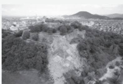
大きく崩れてしまった丸亀城の石垣
