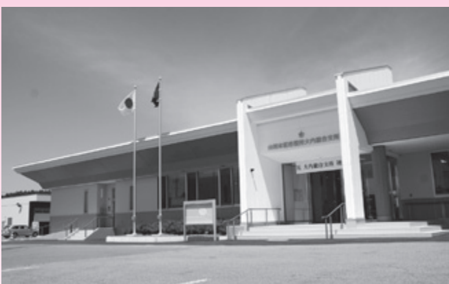
平成29年度に完成した大内総合支所庁舎
