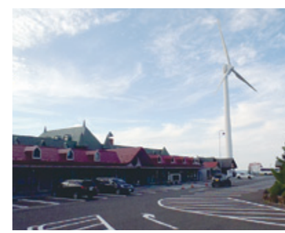
道の駅岩城の風力発電機
