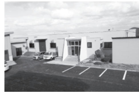
改良工事された蟻山浄水場
