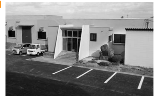
全面改修された蟻山浄水場
