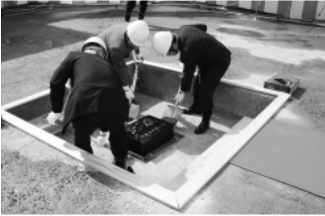
ダム本体底部に礎石を鎮定
