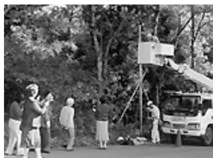
街路灯の設置工事を見守る会員たち
