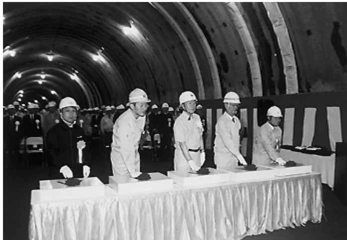
掘削機械の作動ボタンを押してトンネルを貫通させる出席者
