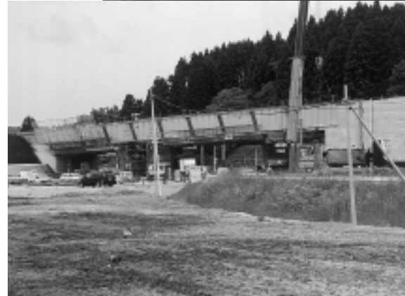
国道105号 深沢ご線橋
