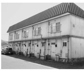
市営住宅(滝沢館)
