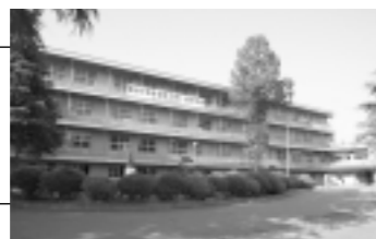
矢島中学校（矢島町七日町） 生徒数：145人（6学級） 現校舎：鉄筋コンクリート造り4階建て 建設年：昭和31年
