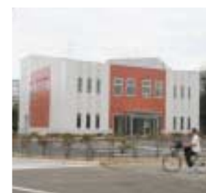
完成した新・第二庁舎
