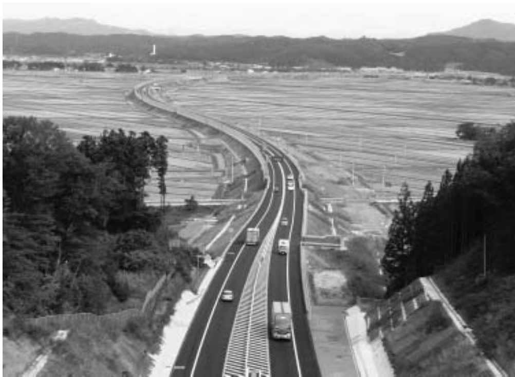
開通した仁賀保本荘道路（西目出戸付近）
