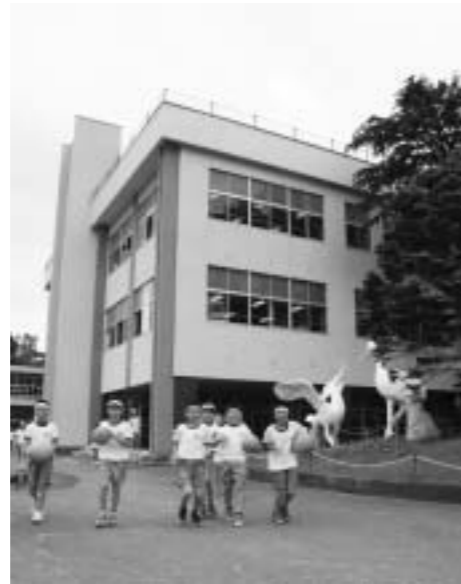
耐震診断を実施した鶴舞小学校
