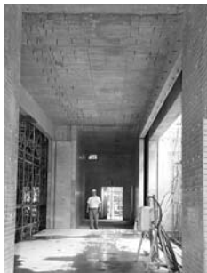
ホール(左)と市民活動室との接続
