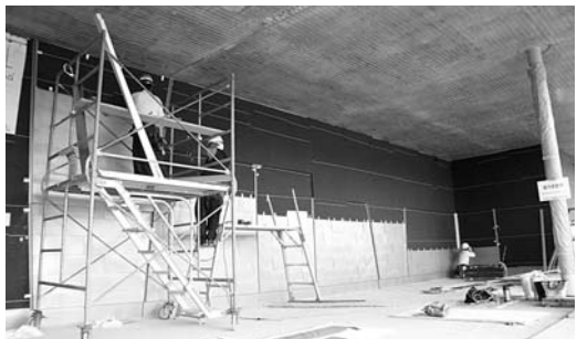
ギャラリー外壁の仕上げ工事
