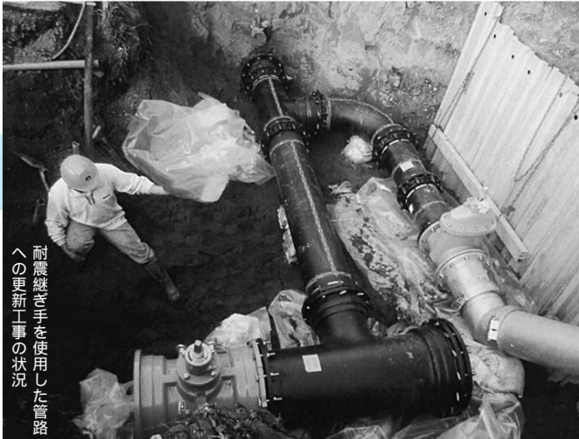
耐震継ぎ手を使用した管路への更新工事の状況
