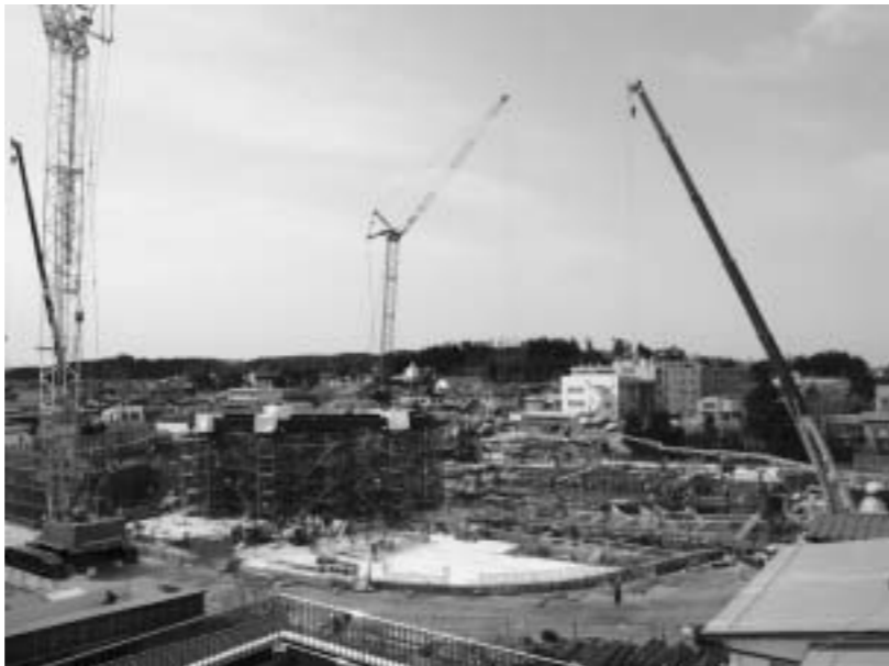
着々と進む「文化複合施設」建設工事
