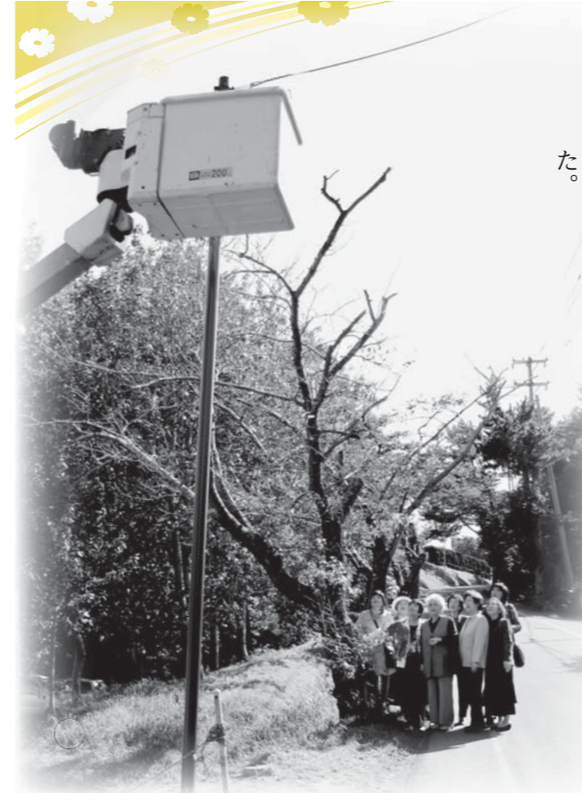
街灯の設置工事を見守る会員の皆さん
