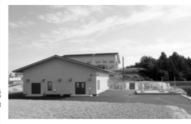
①取水ポンプ場 中島沈澄池からの原水を浄水管理棟着水井へ送ります。
