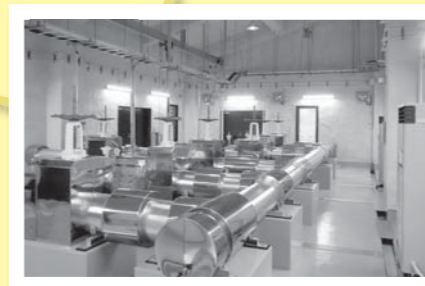
①取水ポンプ場 中島沈澄池からの原水を浄水管理棟着水井へ送ります。
