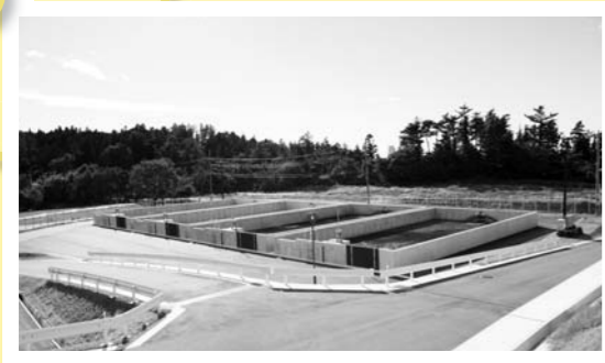
⑤天日乾燥床 てんぴかんそうしょう 濃縮槽で濃縮された泥を天日乾燥します。 RC造 4床 1床当たり 12メートル×25メートル×1メートル 300立方メートル
