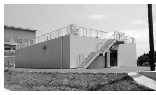
④排水池・濃縮槽 排水池は沈殿池からの水、ろ過池を洗った水を一時的に溜めておくところです。泥と水を分離し水は浄水管理棟着水井へ返送します。 RC造 2池 1池当たり 4.4メートル×5メートル×3.5メートル 77立方メートル
