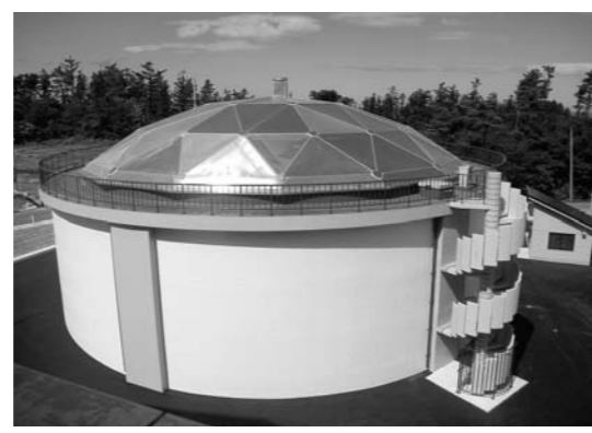
③PC配水池 由利原浄水場でつくられた水は、このPC配水池にいったん貯められます。災害時にはその貯留した水を非常用水として使います。 PC造 直径 23.8メートル 高さ 8.2メートル アルミドーム 直径 20.8メートル 有効水深 6.8メートル 容量 3,000立方メートル
