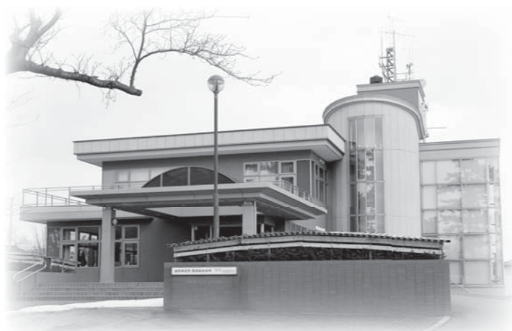
西目総合支所庁舎
