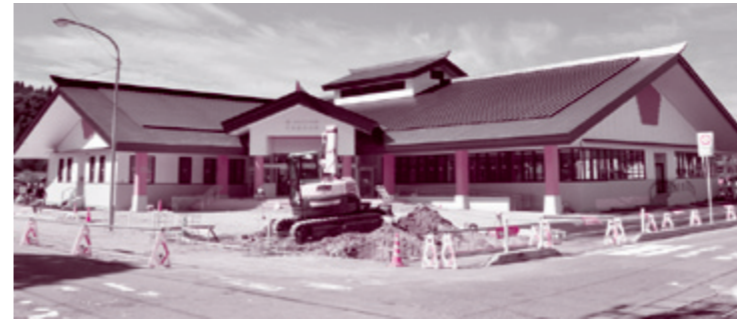
建物の仕上げや外構工事が進められています
