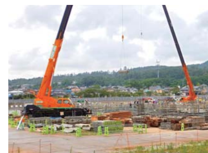
工事の進む建設現場
