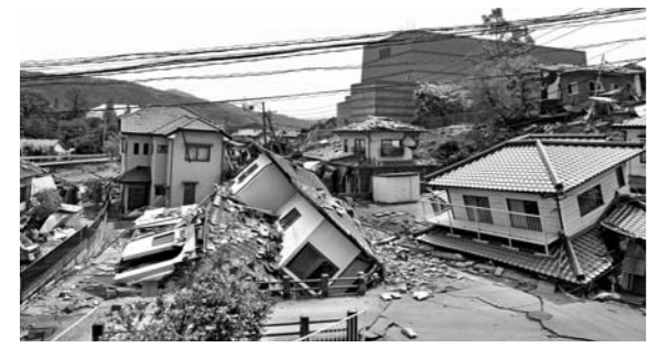
熊本地震により家屋の倒壊した熊本県益城町の中心部(広島大学提供)
