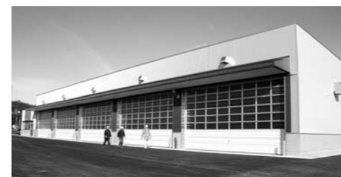
川口地区に新設された除雪ステーション
