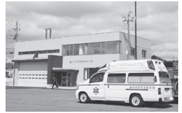
本荘消防署東由利分署の新庁舎
