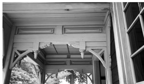
玄関ポーチ上部の装飾
