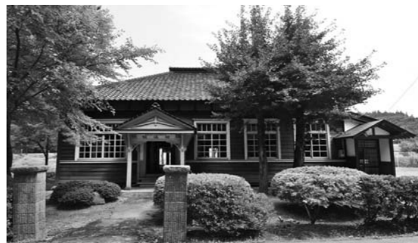
旧大倉沢報徳館正面外観
