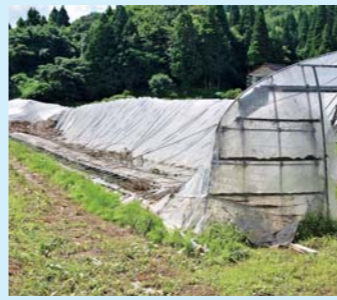
芋川の氾濫によって押しつぶされた農業用ハウス(徳沢)
