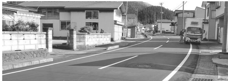
劣化した路面を新しく舗装整備した市道大琴中央線
