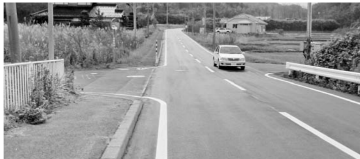
路面のひび割れやわだちなどの修繕・舗装を行った市道道川中央線
