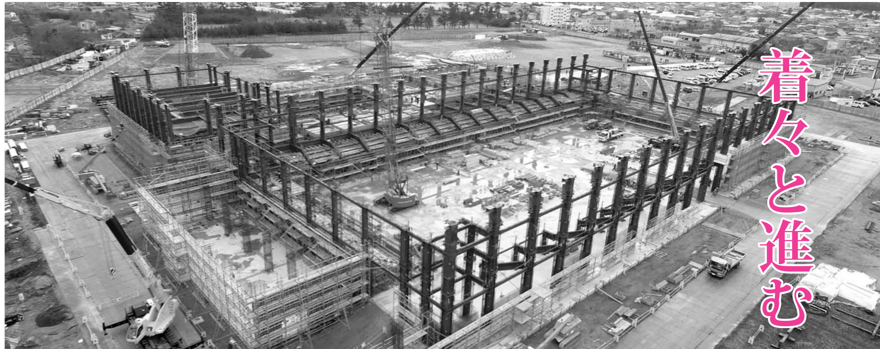
鉄骨の組み立てや1階部分の鉄筋・型枠などの取り付けが進む総合防災公園「アリーナ」（昨年11月30日撮影）
