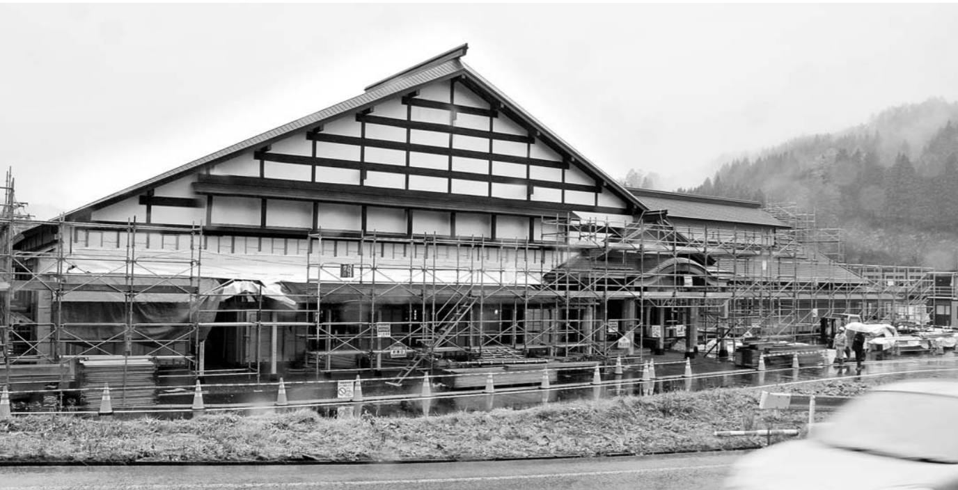
国道108号沿いに建設中の民俗芸能伝承館「まいーれ」（昨年11月27日撮影）
