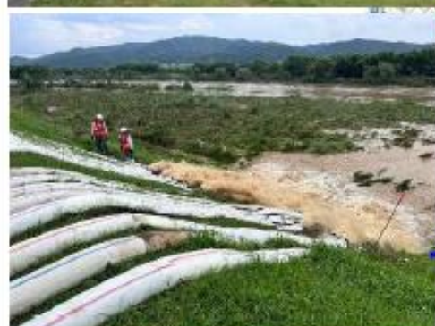
石沢川左岸排水状況[R6. 7. 26]
