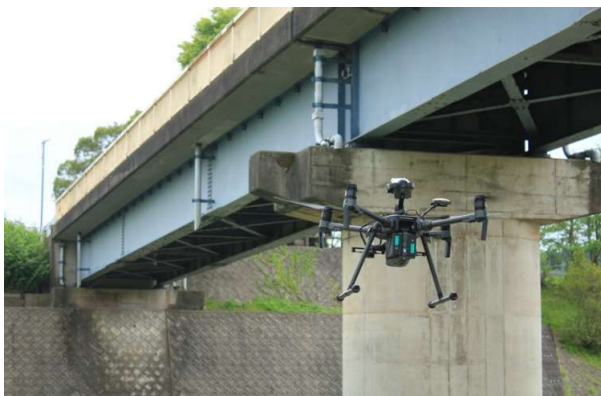
ドローンによる点検状況
