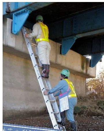
写真3.2 梯子による点検
