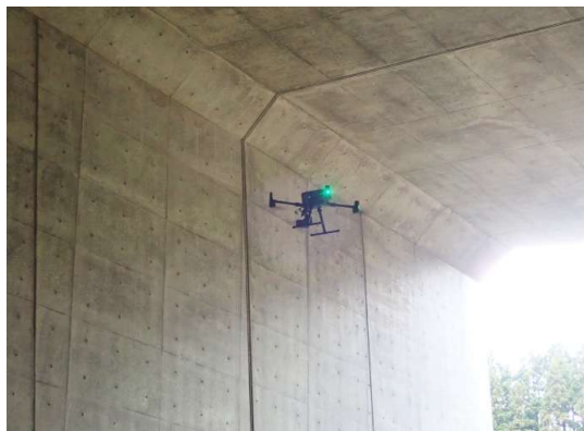
ドローンによる点検状況
