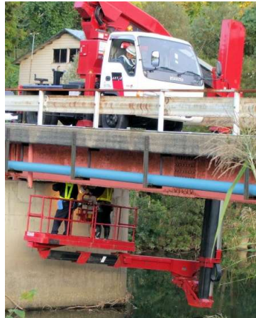
写真3.3 点検車による点検
