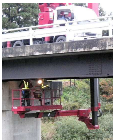
写真3.3 点検車による点検
