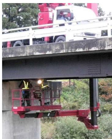
写真3.3 点検車による点検
