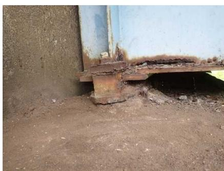
鋼製支承の沓座モルタル欠損、傾斜
