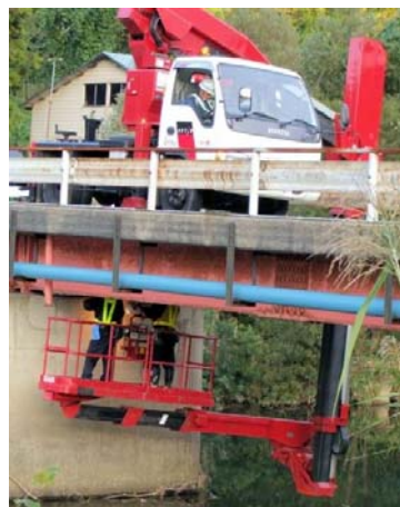
写真3.3 点検車による点検
