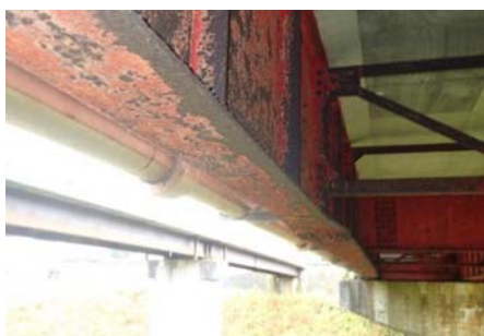
鋼桁の腐食
