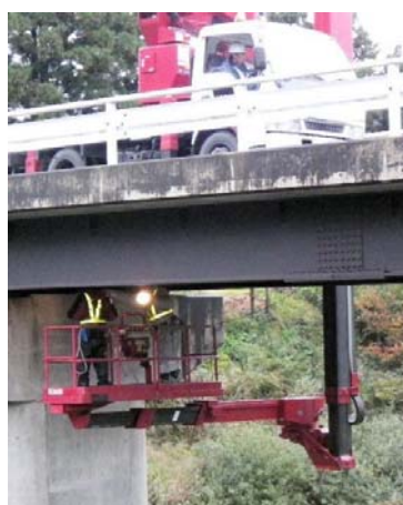
写真3.3 点検車による点検
