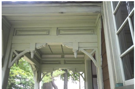
玄関ポーチ上部装飾
