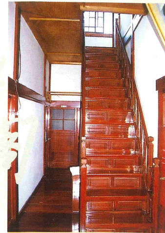
◆養老閣 階段室内観(箱階段形式)
