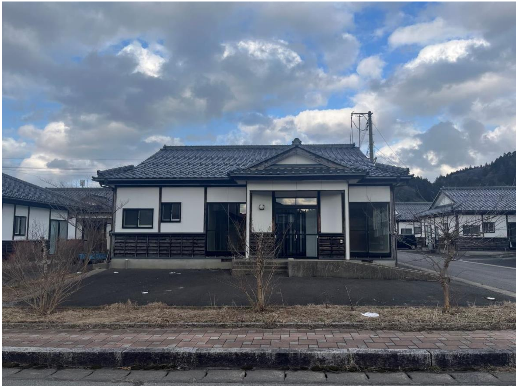
【岩城地域】 田町団地 8 号棟（特定公共賃貸住宅）
