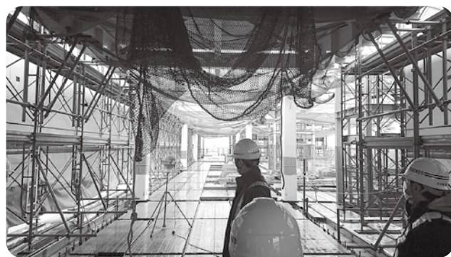
工事中の東西自由通路
