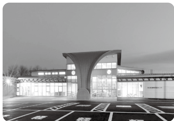
新築された県動物愛護センター
