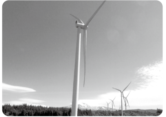
由利原の風力発電施設
