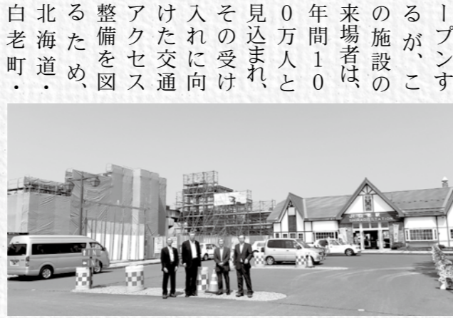
白老駅周辺整備事業(写真左側が工事中の自由通路)
