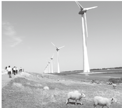
ウェスターメイヤール風力発電所(オランダ)
