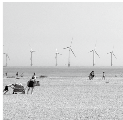
スクロビー・サンズ洋上風力発電所(イングランド)
