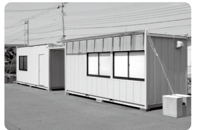
新設された仮設診療所
