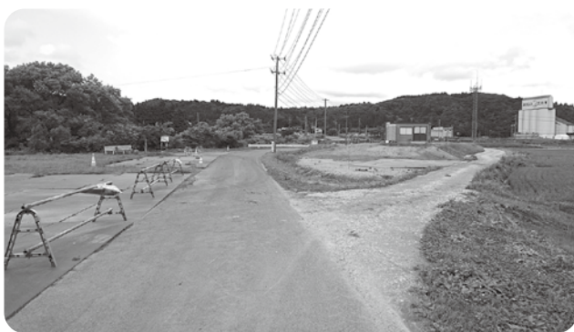
配水管布設替工事予定の徳沢橋付近
