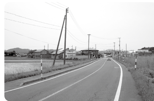
防犯灯新設予定の国道108号（薬師堂～玉ノ池）
