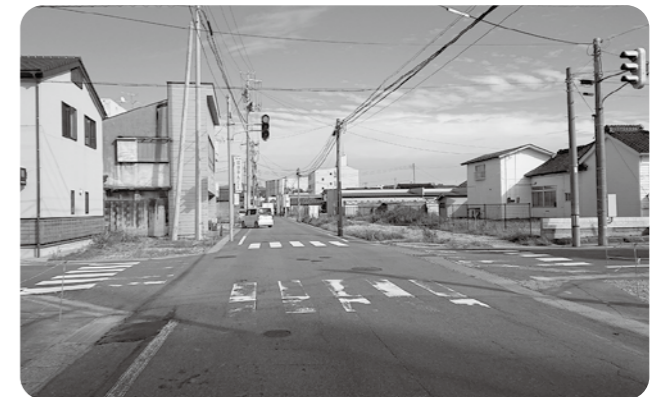
拡幅が進む停車場栄町線
