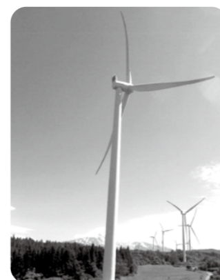
フェンス、施錠、標識がない風車群
